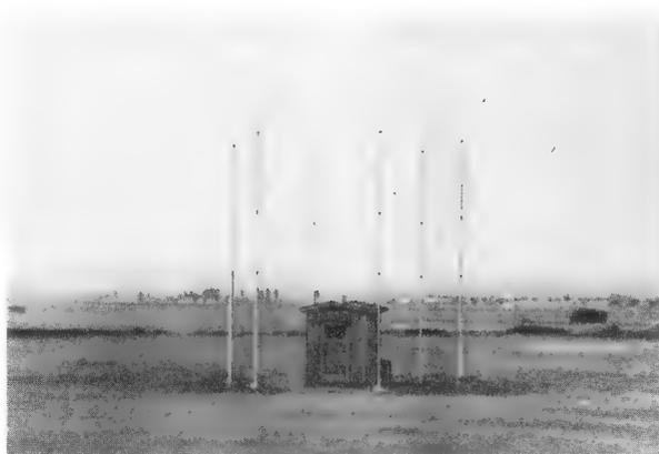
Bild 11. Sechsmast-Kurzwellen-U-Adcock mit unterteilten Masten von Telefunken
